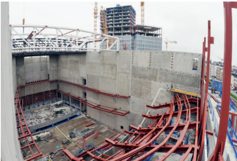
Inre stomme till konsertsalen under pågående montage.
