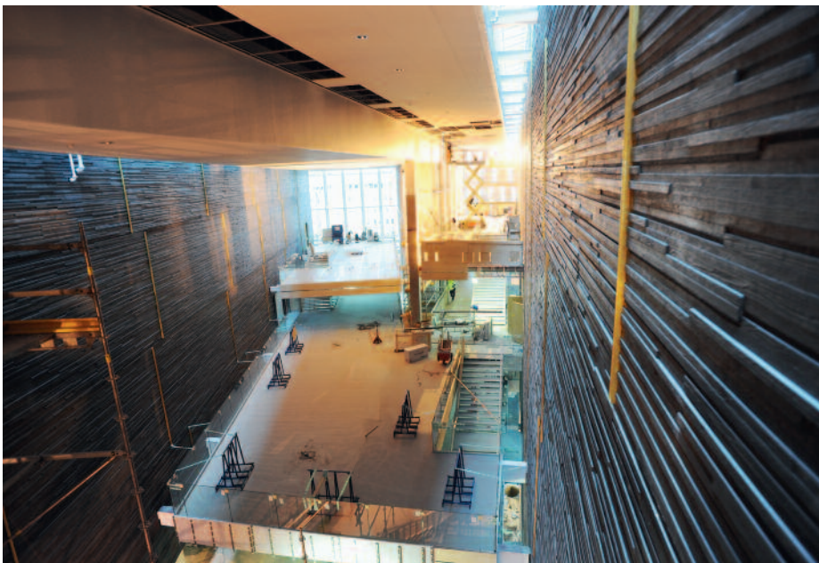
Här ser vi de diffuserande ytor som omgärdar samtliga salar. Det är våningshöga betongelement med cirka 6 m längd som gjutits mot en brädformad yta med varierande tjocklek. I vertikalfogar sitter mässingsarmatur med lysdiodbelysning. Betongelementen fortsätter upp genom taket och ger ovana besökare en förbättrad orientering.
